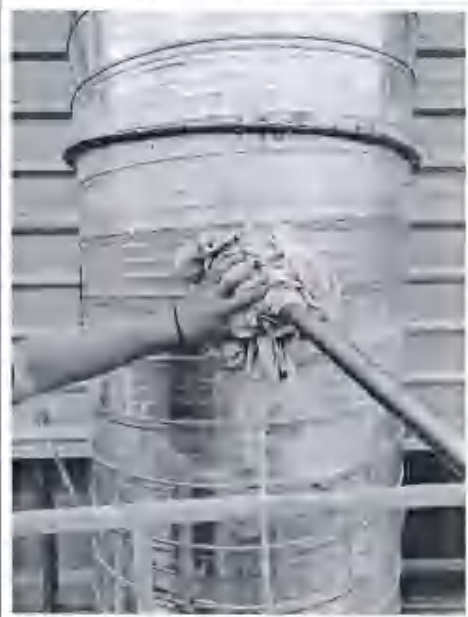
喷漆、烘干(面漆)废气出口
