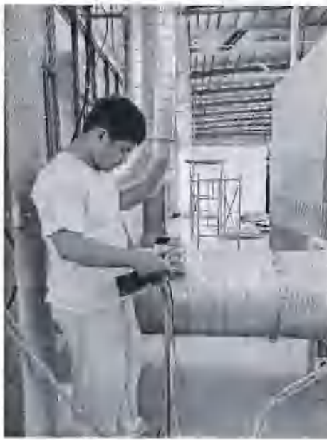
喷漆、烘干(面漆)废气进口
